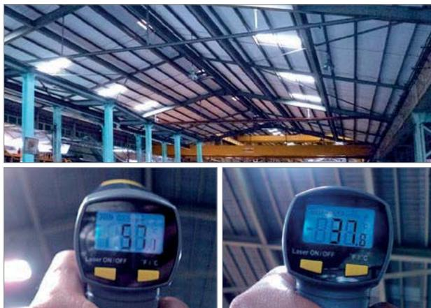
Interior cubierta (antes-después): la temperatura se redujo en 19,3° C. Resultado: mejores condiciones de trabajo, ahorro de energía, reducción de costes de mantenimiento de la cubierta.
